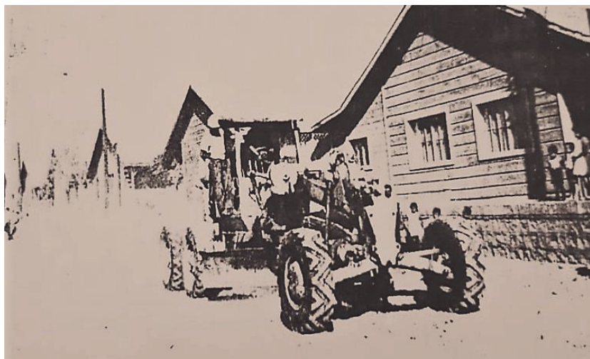
Foto 35 Obras de pavimentación de calles. AGEBCS
