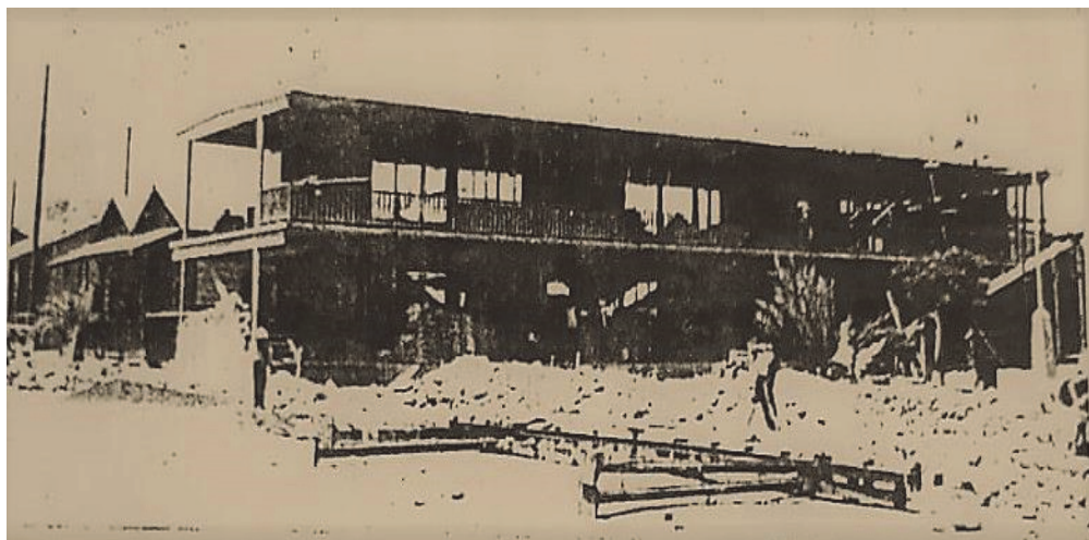
Foto 31 Edificio en construcción de la escuela Antonio F. Delgado. AGEBCS
