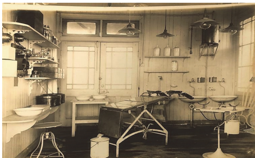
Foto 16 Sala quirúrgica del hospital de El Boleo (AHPLM)
